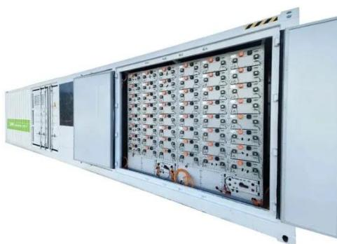
almacena y administra módulos de batería para UPS, telecomunicaciones y almacenamiento de energía, lo que garantiza la seguridad, la escalabilidad y la eficiencia.
